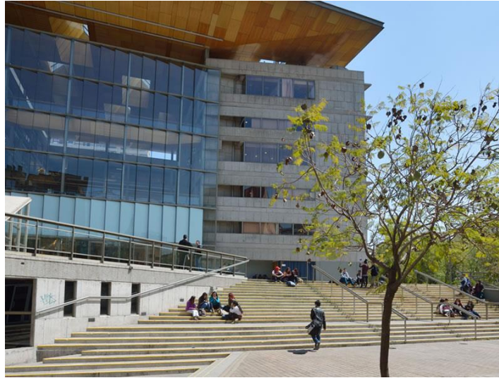
ILUSTRACIÓN 1. Edificio Vicente Kovacevic II. Sede Santiago.
