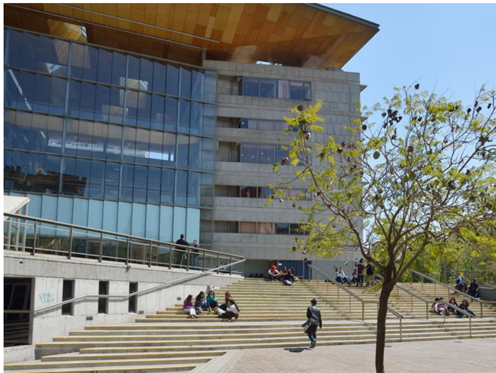
ILUSTRACIÓN 1. Edificio Vicente Kovacevic II. Sede Santiago.
