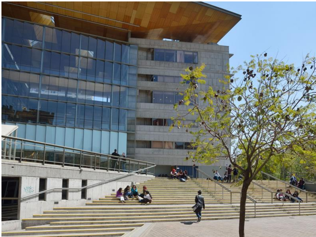
Ilustración 1. Edificio Vicente Kovacevic II. Sede Santiago.
